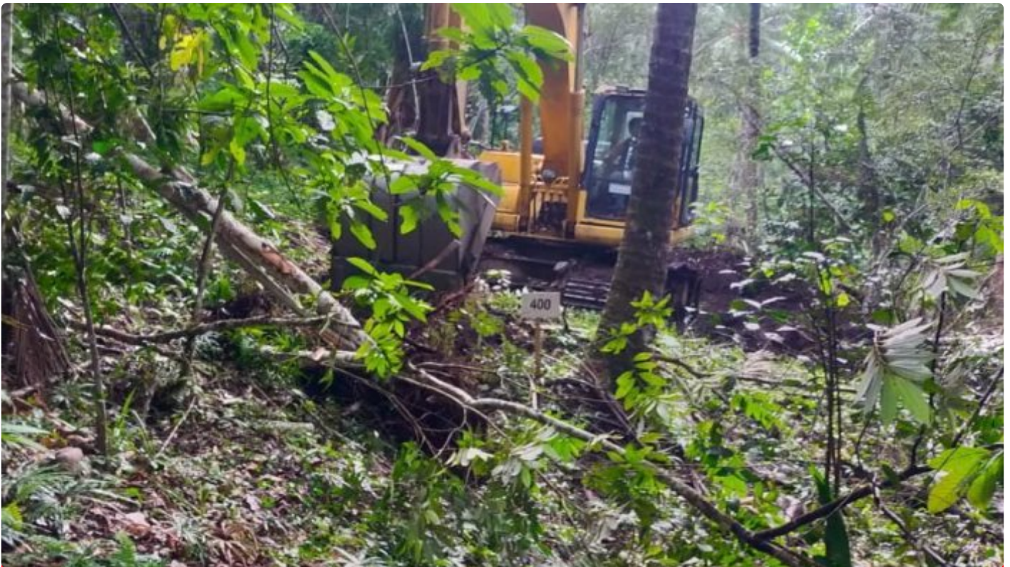
Pekerjaan akses Jalan TMMD Ke-116
